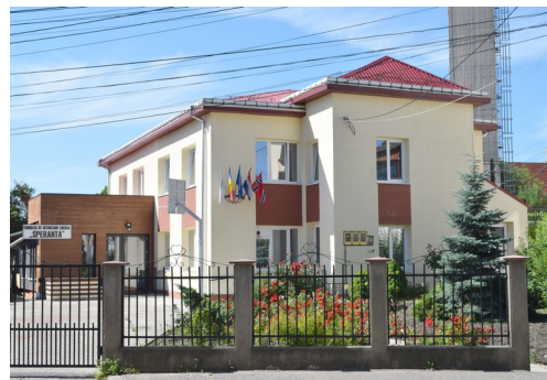
Clădirea după lucrările de investitii realizate de fundatie în 2015 - 2016
